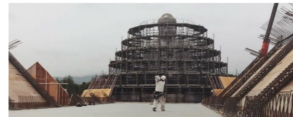
مخروط ناقص اطراف بودا در مرحله اجرا
